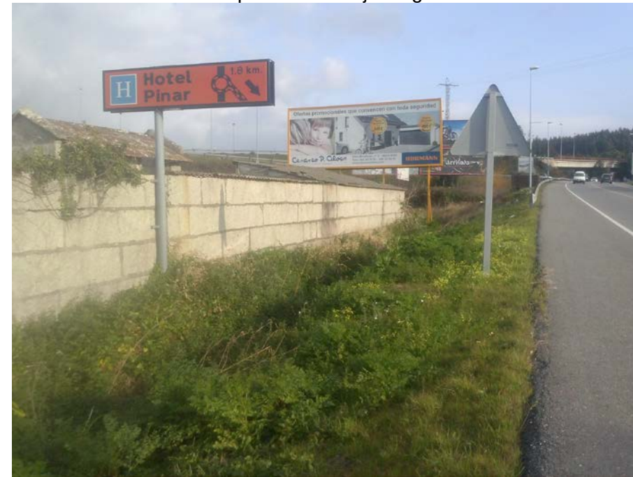
Cuneta en tierras en pk 0+070 margen izquierdo
