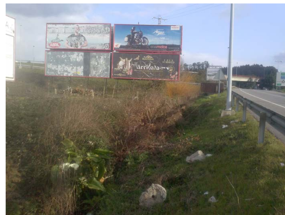
Talud y cuneta en tierras en la futura zona de ocupación del nuevo ramal
