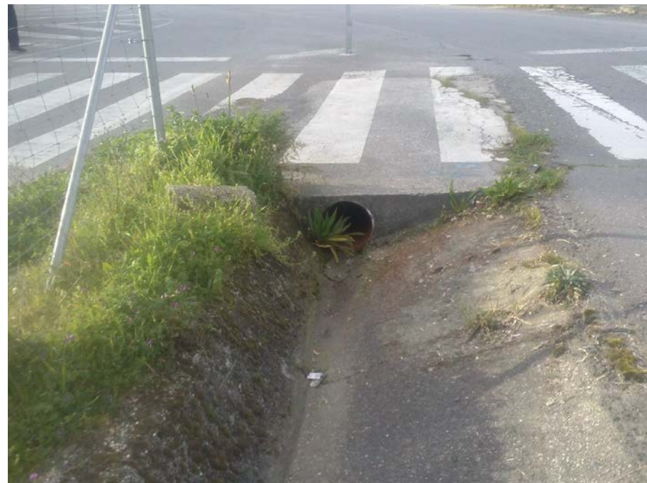
Final de cuneta en pk 0+000 y colector bajo glorieta
