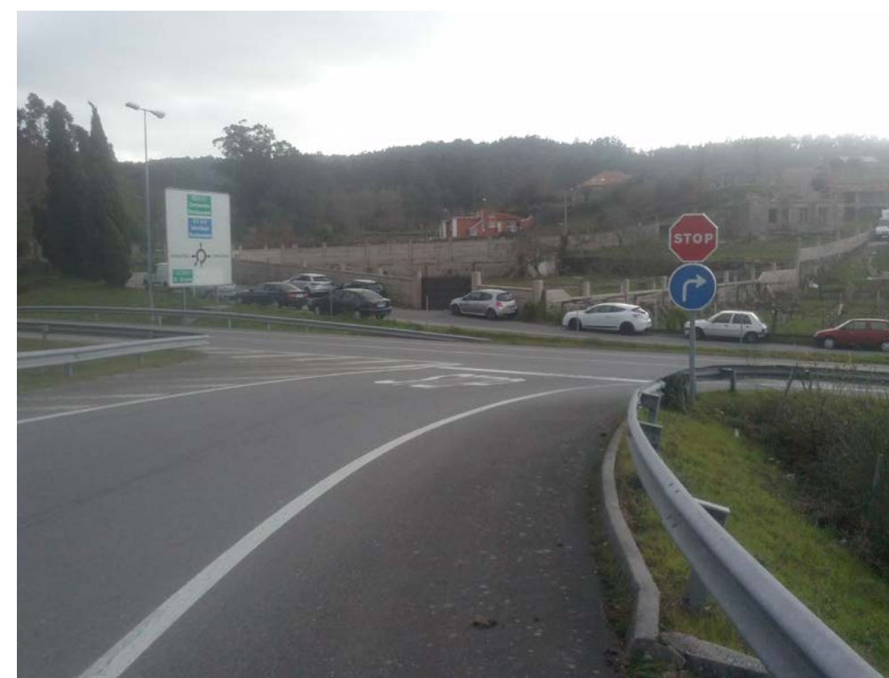
Disposición del Stop al final del ramal
