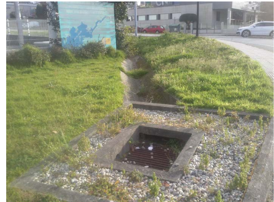
Cuneta y arqueta lateral existente en zona by pass
