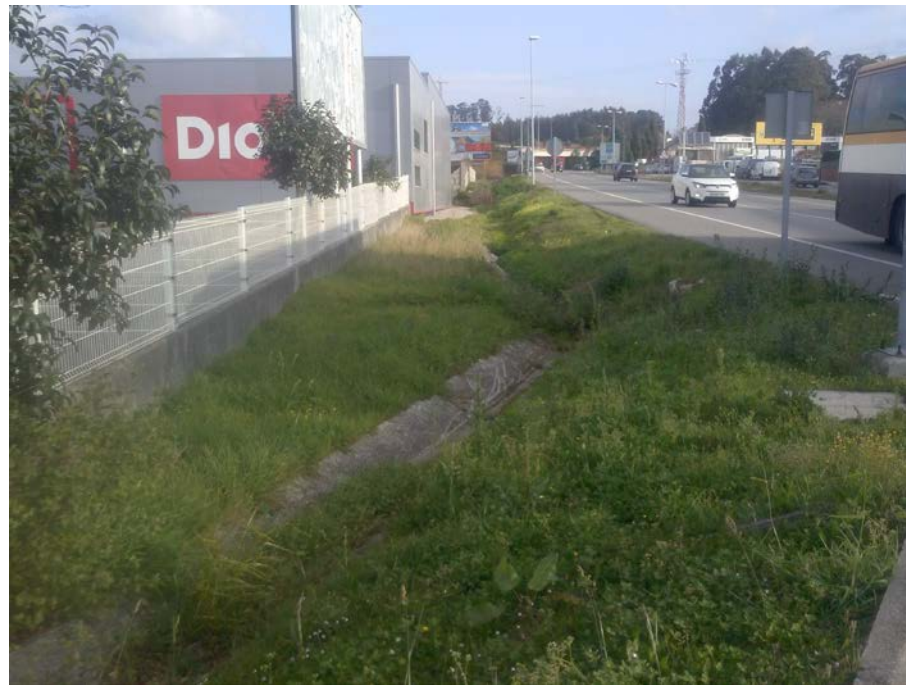
Cuneta revestida en margen izquierdo del inicio del Acceso GL y by pass
