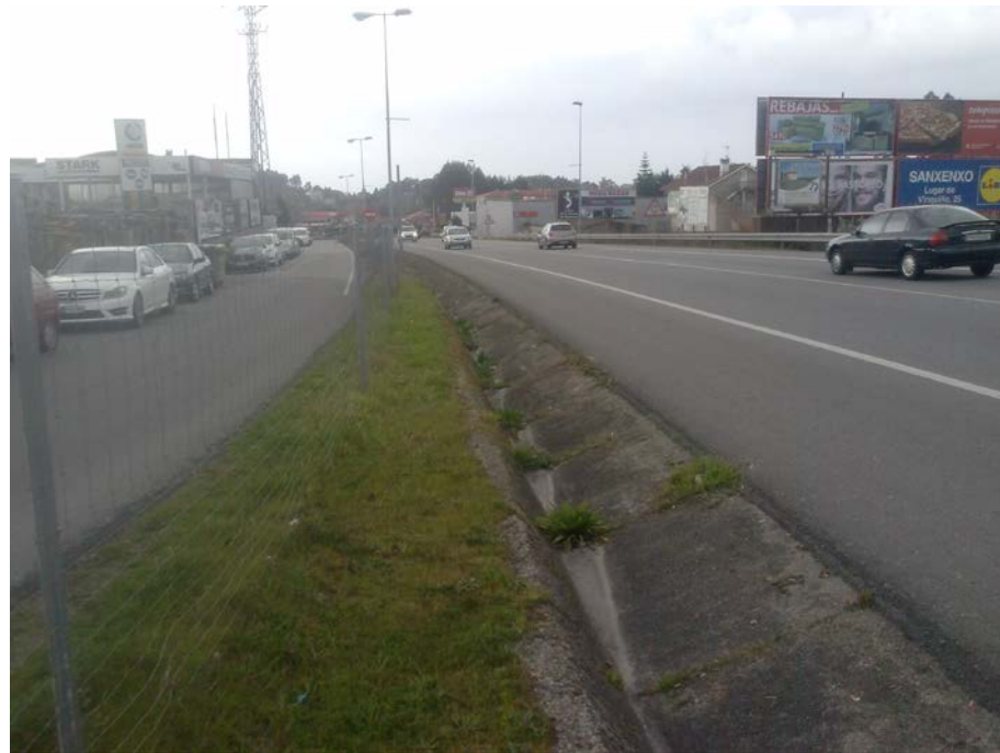
Cuneta existente en el margen derecho del Acceso GL
